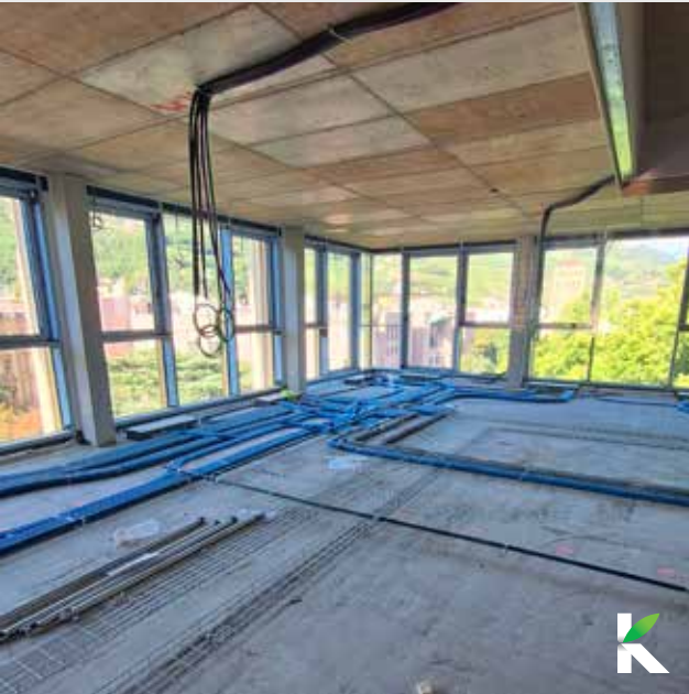
UFFICI BURO A WALTHERPARK Realizzazioni impianto idrico-sanitario, climatizzazione estiva/invernale e ventilazione degli uffici Buro A.
